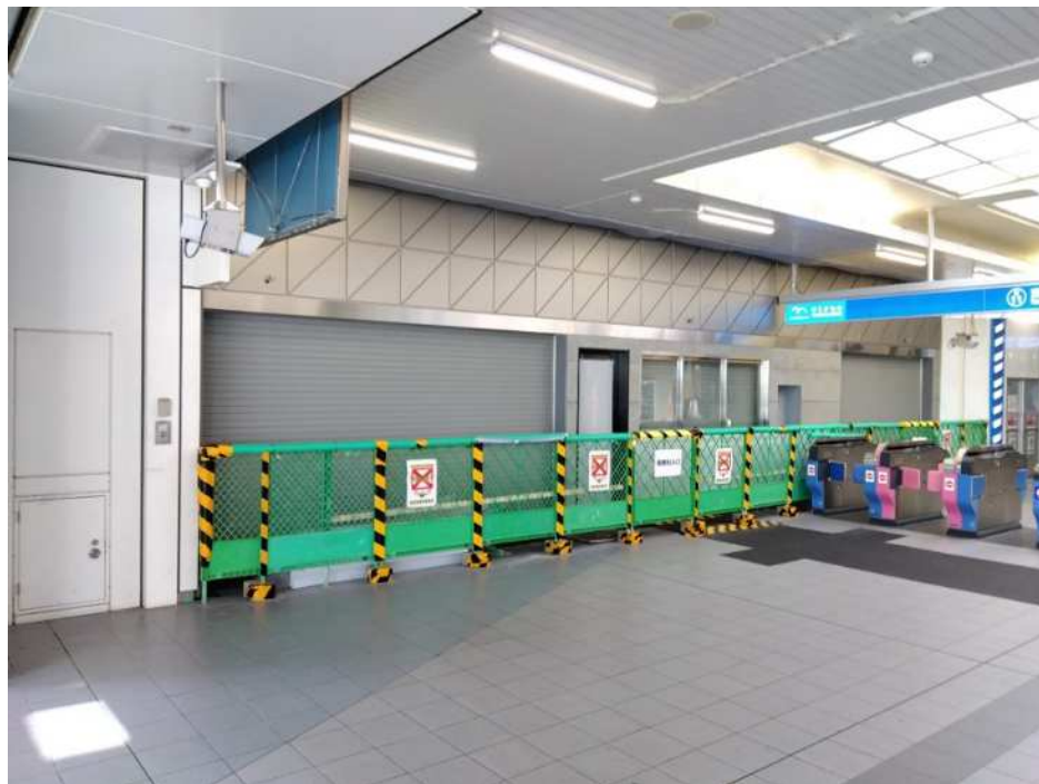
駅務室 外装完成状況
