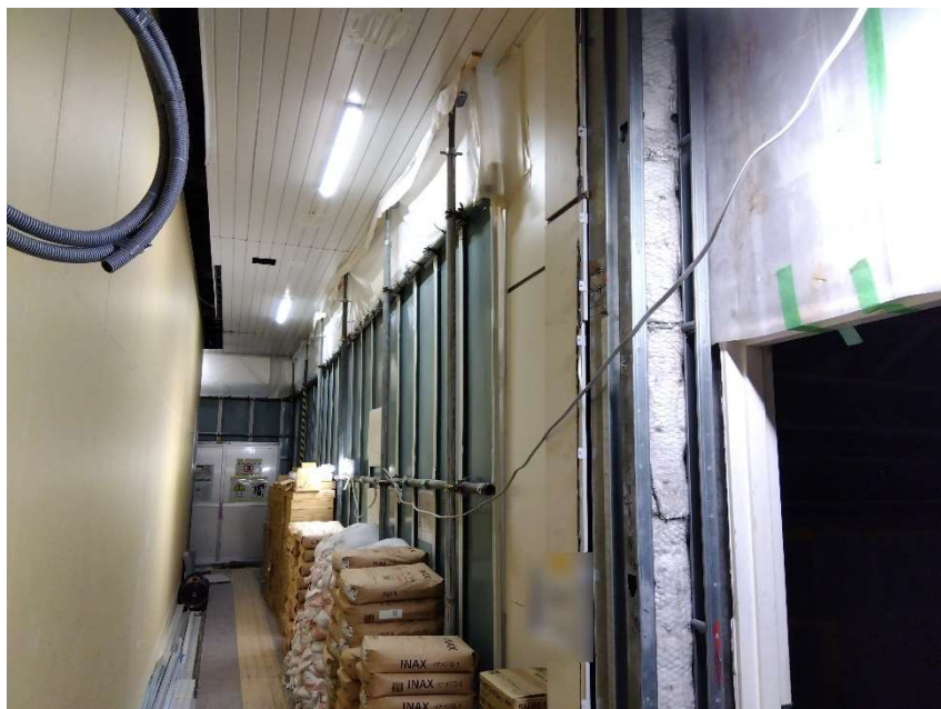
トイレ前通路建築中
