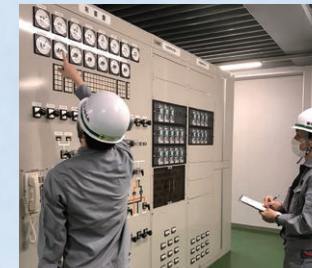
変電所設備の点検
